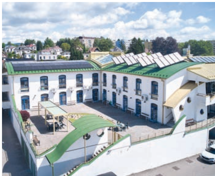
Červenokostelecký hospic dostal po 30 letech nový kabát. Při rozsáhlé renovaci se podařilo instalovat i fotovoltaické panely. Tyto úpravy sníží provozní náklady a zlepší komfort pro pacienty i jejich blízké.
